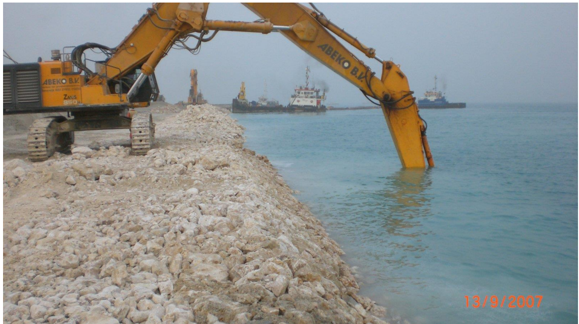
Figura 11-3 – Colocação de enrocamento por meio de guindaste.
