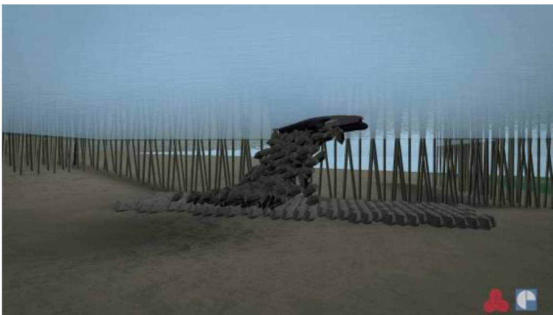
Figura 11-7 – Barcaça do tipo Split depositando o material do núcleo.
