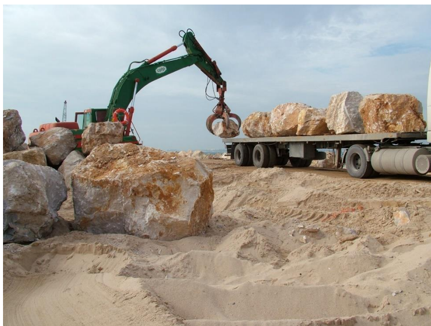
Figura 11-2 – Descarregamento de material pétreo para o enrocamento.
